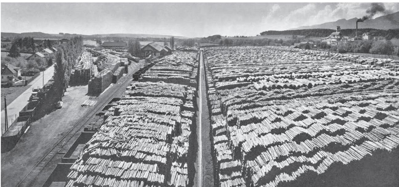
Der riesige Holzplatz der Cellulosefabrik lag am Südufer der Aare und fasste mehr als 400 000 Ster (1 Ster = 1m<sup>3</sup> geschichtetes Holz inklusive Zwischenräume). Foto aus «75 Jahre Cellulosefabrik Attisholz AG», 1956.
